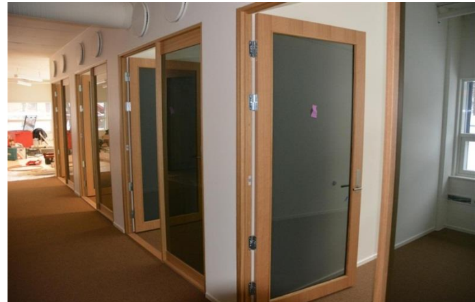
Gjenbruk av gammel fasadeglass
