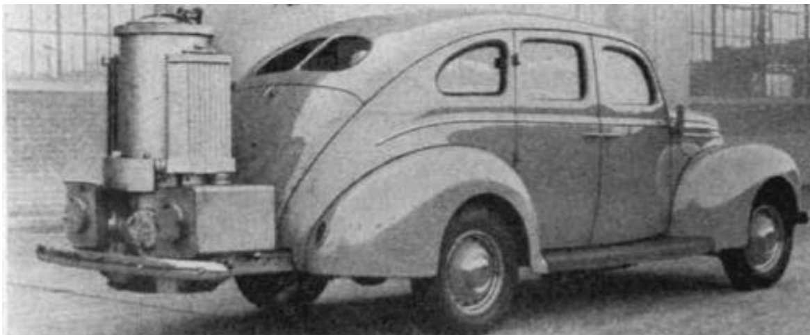
Abb. 2. Pkw mit einer hinter dem Kofferraum angebauten Holzgas-Generatoranlage Der Aufbau wird in keiner Weise durch die Anlage verändert
