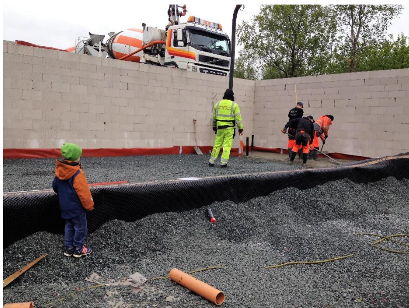
Grunnmur og støyping av grovbetong
