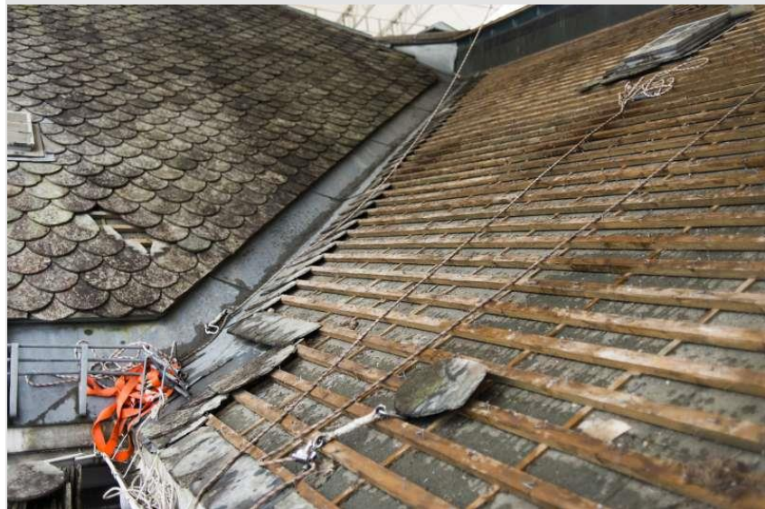
Campus Ås, NMBU Urbygningen - Restaurering av tak
